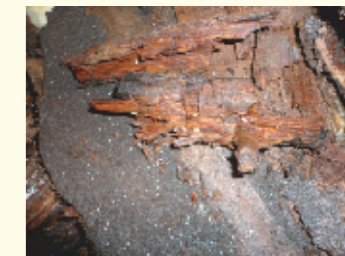
シロアリの被害例
